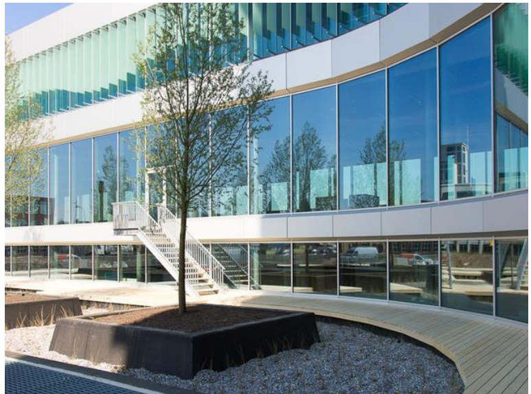
Soll den Mitarbeitern ein "Wohlfühl" vermitteln: Das neue Rathaus von Venlo, hier der Innenhof. (Foto: Ton Desar/Gemeente Venlo)
